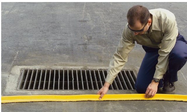
ブロッカーを地面に置き、底部のビニールラップをはがし、粘着部を地面につけ、上から押して密着させます。
